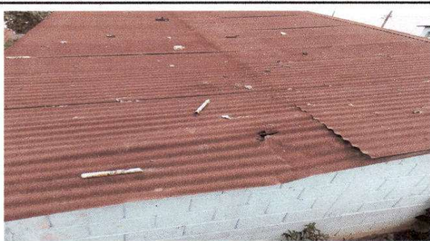
Foto 1. Sustitución de lámina, por lámina troquelada aluzinc calibre 26 + Sustitución de capote de lámina, por lámina troquelada + Sustitución de elementos de fijación
