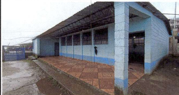
Foto 4. Pintura en muros exteriores e interiores
