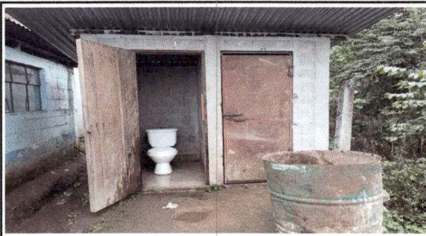
Foto 2. Sustitución de puerta en servicios sanitarios
