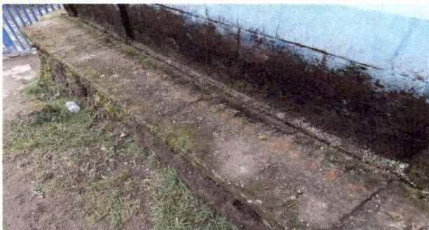
Foto 3. Sustitución de piso de torta de concreto
