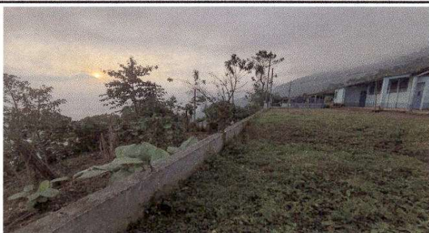
Foto 5. Reparación de muro perimetral de block
